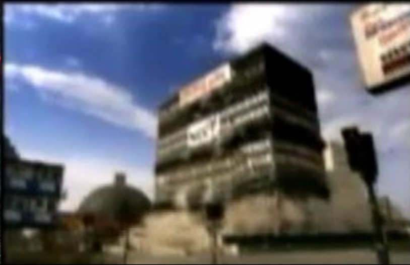
Une démolition contrôlée
