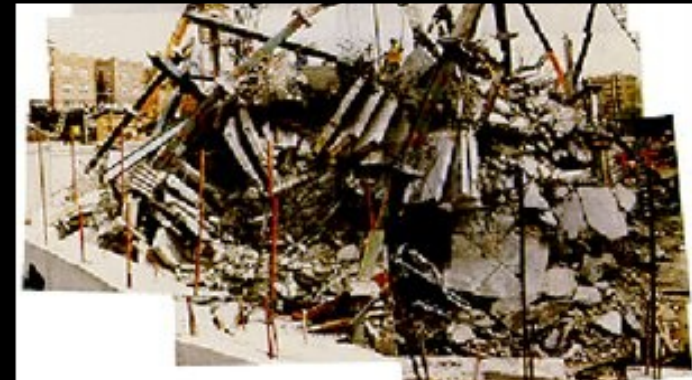
Un effondrement (Tremblement de terre) ?
